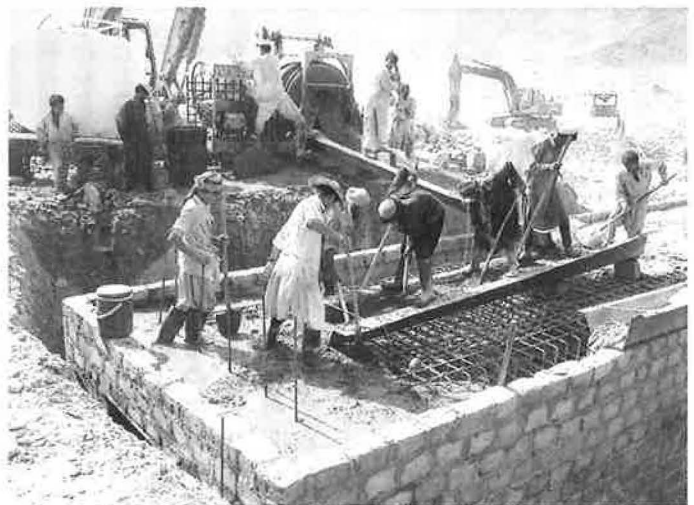
水道橋の架橋工事（橋の下を水が通る）。米軍主導の道路工事に備え、二つの横断部を最初に完成させた
