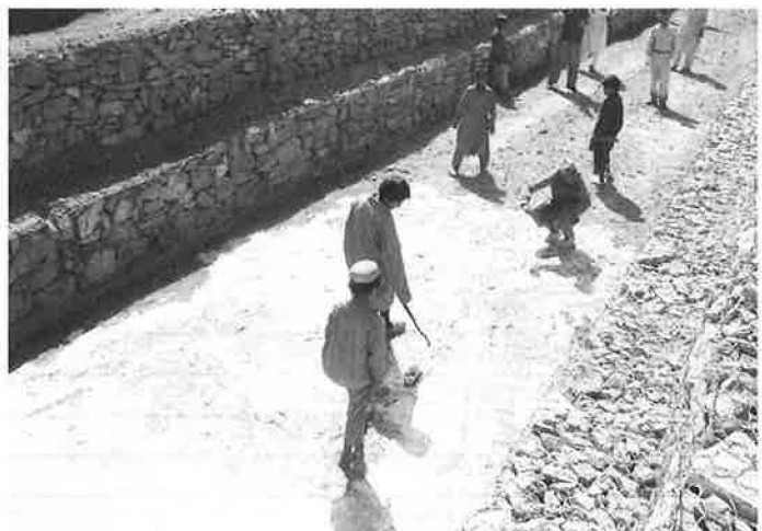
灌漑用水路の部分通水直後の様子
