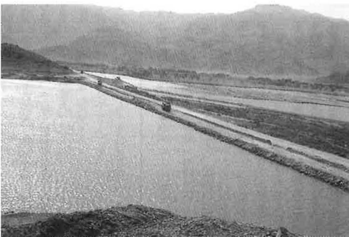
取水口から二キロメートル地点にある巨大な貯水池。
