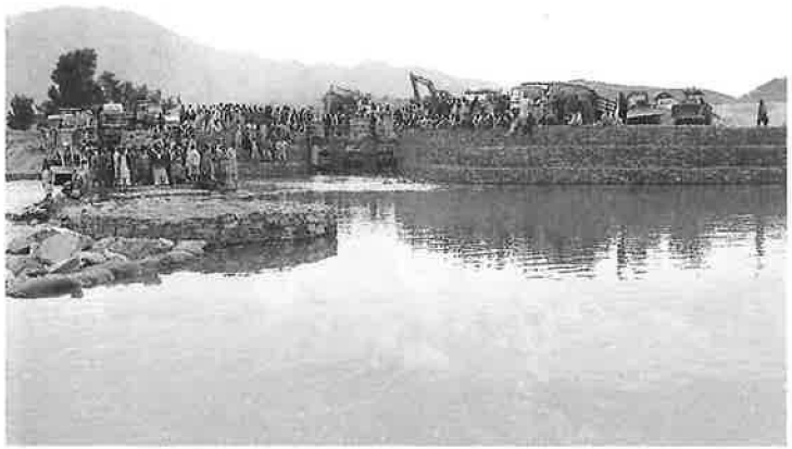
苦心の末、取水口工事を完遂した現地作業員たち
