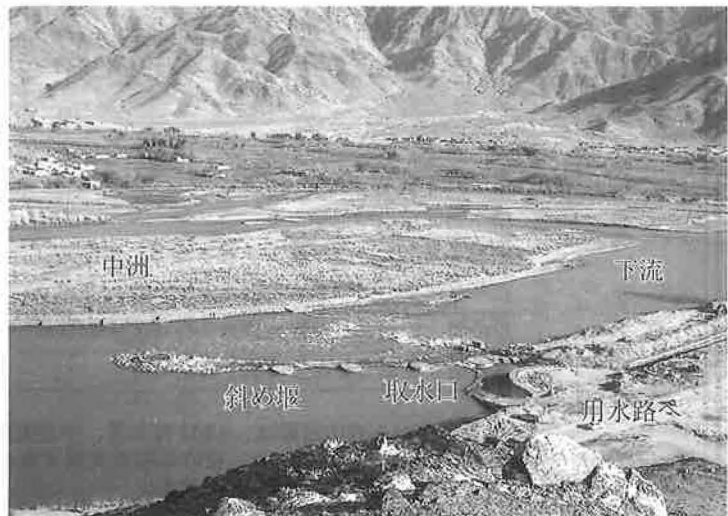
完成した取水口周辺部（クナール河沿い）
