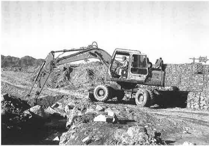
自ら重機を操り工事の陣頭に立つ中村医師
