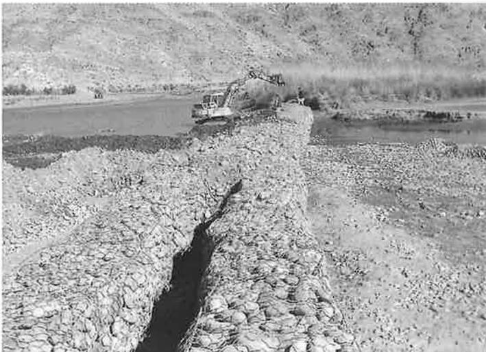
クナル川の築堤工事（手前に大量の蛇籠が見える）
