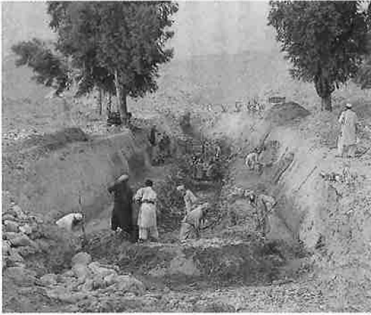
掘削が進む用水路
