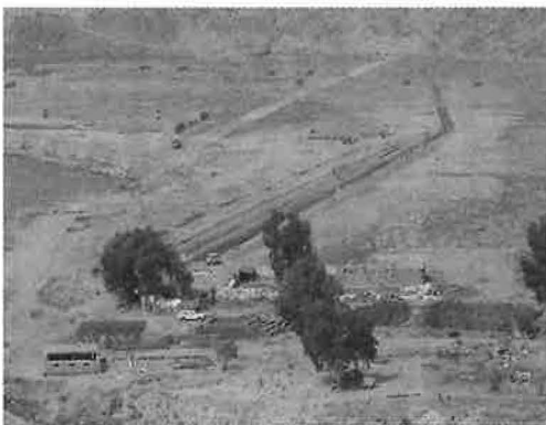
年内に6キロの掘削が完了する用水路遠景
