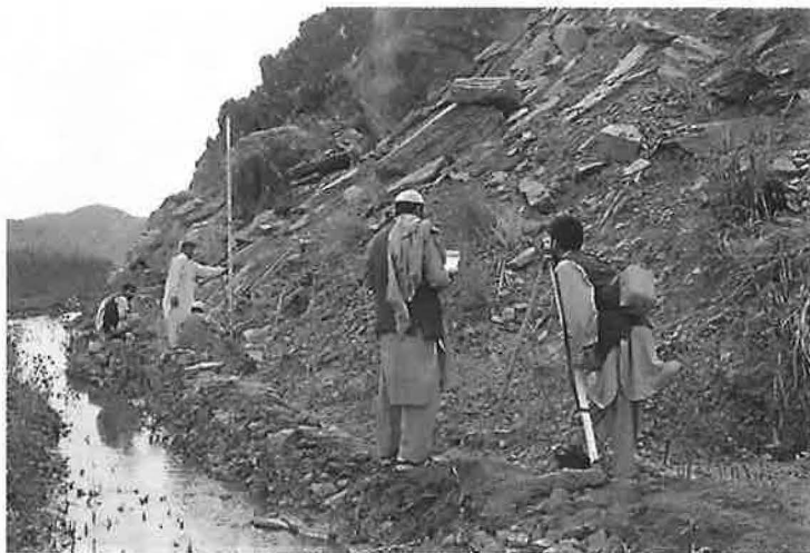
用水路建設のための測量を行う現地スタッフ
