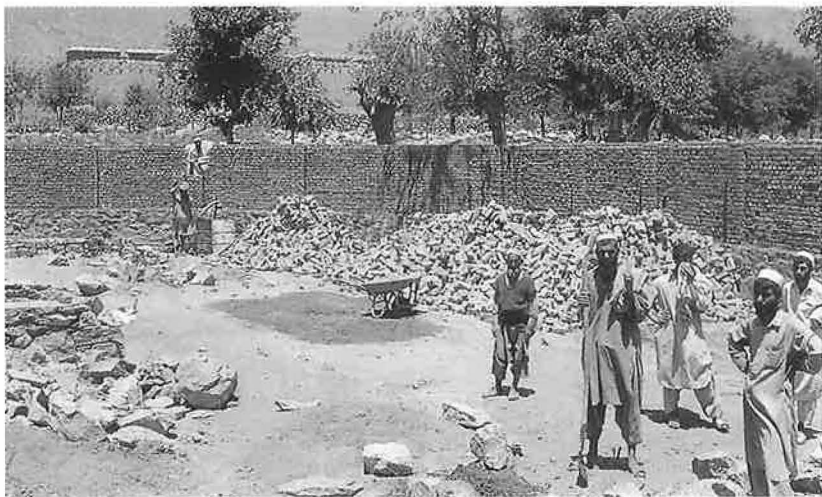
建設中の「オキナワ・ピース・クリニック」(ダラエ・ピーチ)
