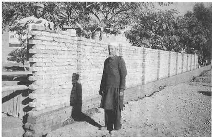
新病院の外壁もでき、いよいよ着工
