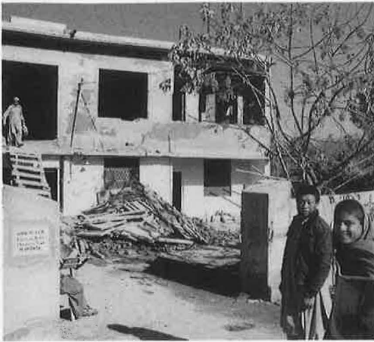
▶建設中のアフガン・レプロシー・サービス
