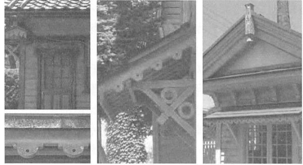
左上:写真11 旧第四高等中学校門衛所の庇/左下:写真12 同・軒先拡大 註18) 中:写真13 旧山形師範学校音楽練習堂の庇/右:写真14 同・門衛所の庇 註18)
