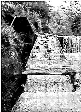
図1 捨て石型（渓床型）実験魚道（10段）全体。
