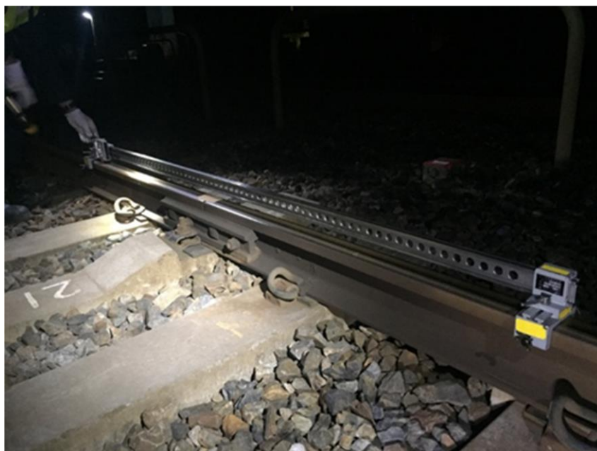
図 3-9 2m ストレッチによる継目部凹凸の測定状況
