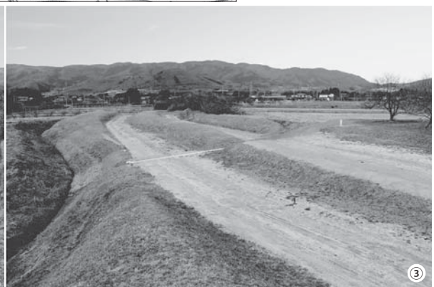
下二重堀地区 南西から
