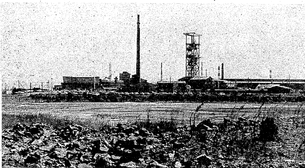
四山鉦周辺には広大な空地が(海側から駐車場を望む)
