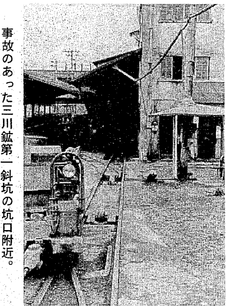
事故のあった三川鉱第一斜坑の坑口附近。
