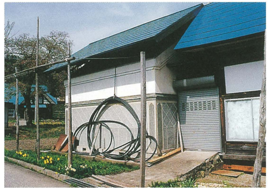
図46 人造石洗い出しの土蔵（福島県大沼郡金山町）
