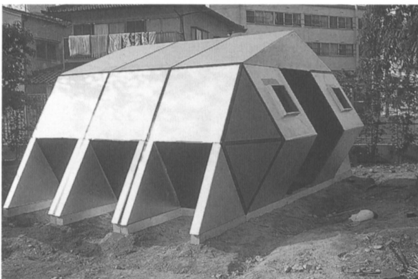
完成したシェルター
