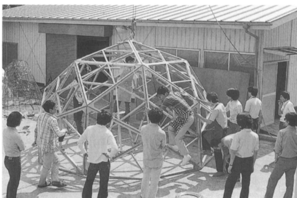
フーラードームの骨組みの製作
