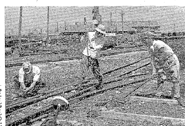
写真三川坑外で働く入替採用の人たち
