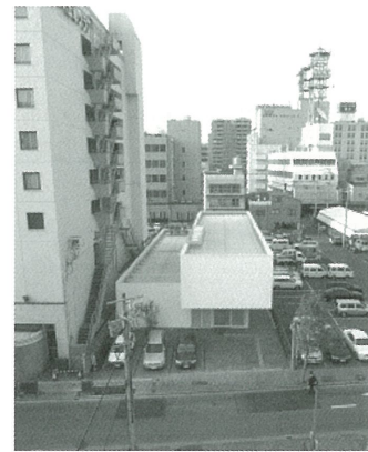
写真-8 南側ファサード(俯瞰)
