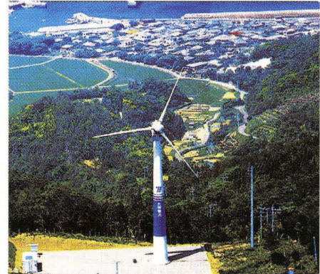
(c)C風力発電所
