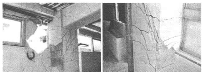
写真2. 水平加力実験後の観察対象部分の様子：壁面（廊下側）、柱（中庭側）
