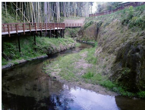
写真2-6 裂田溝の火砕流堆積物開鑿
