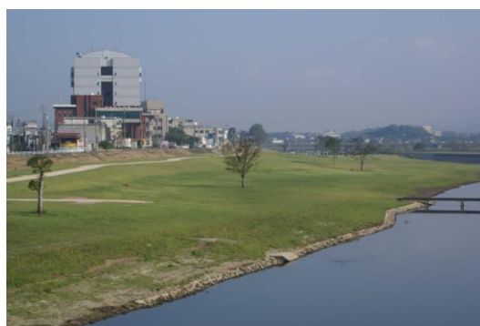
写真4-40 緩傾斜河岸の改修後（2006年9月）
