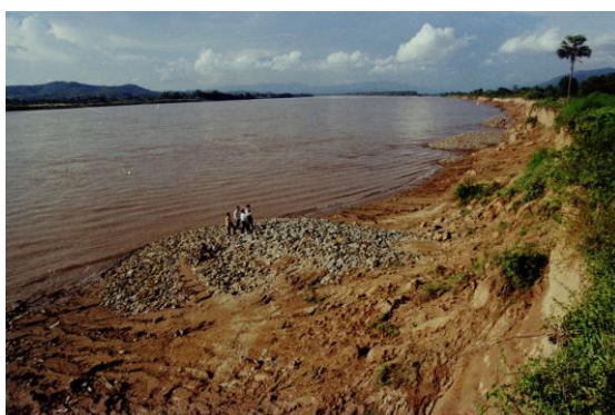
写真 4-9 建設中の3,4号基（1998年10月）
