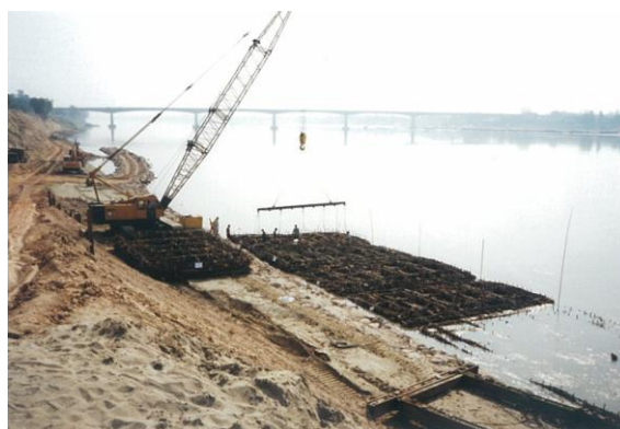
写真 4-33 陸上大型クレーンによる沈設 (2003)
