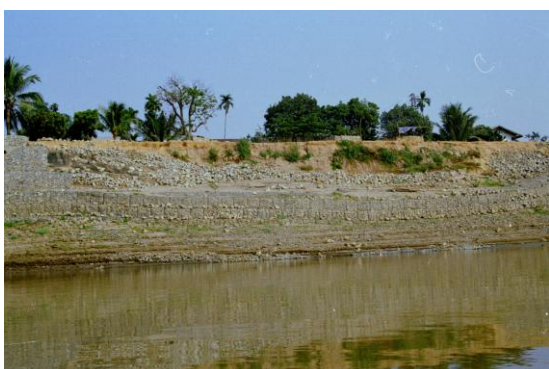
写真4-20 蛇籠護岸の滑落 (1998年2月)
