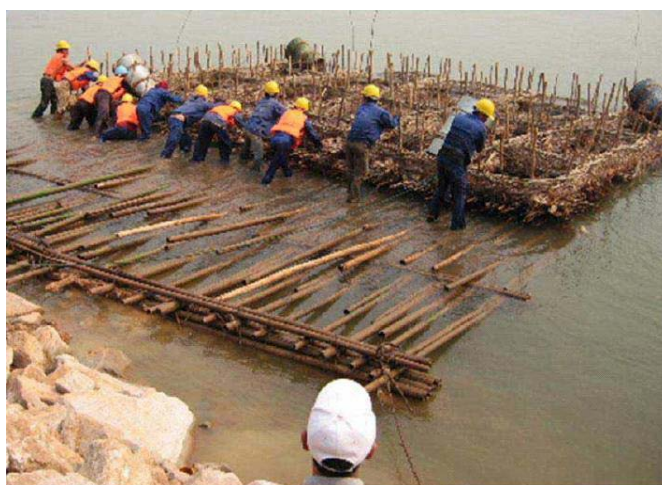
写真 4-34 筏上で製作した粗朶沈床の水上移動 (2008)
