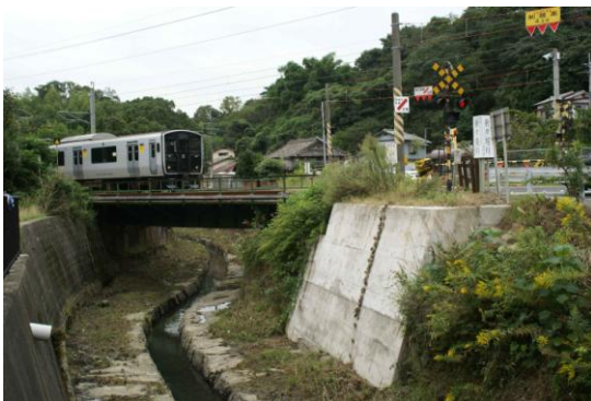
写真 2-16 遠賀堀川と筑豊鉄道 (JR) との交差
