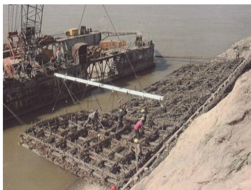
写真 4-32 台船上のクレーンによる沈設 (2001)
