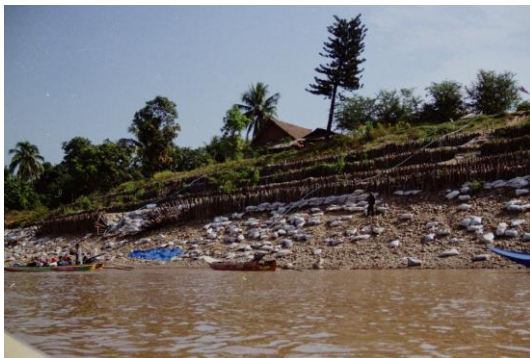
写真 4-5 船着場の河岸保護 (1997 年 11 月)
