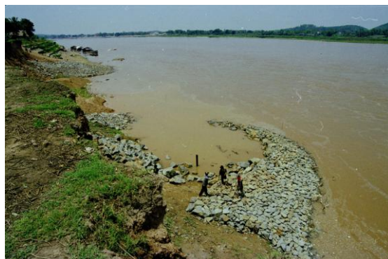
写真 4-8 建設中の1,2号基（1998年5月）
