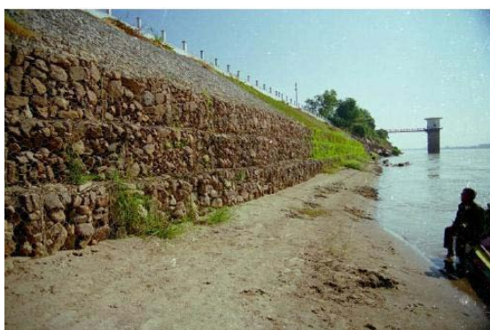
写真4-24 蛇籠で保護された河岸 (1998年1月)
