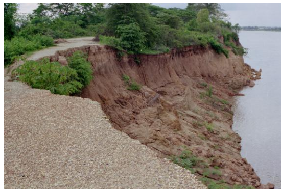
写真4-19 堤防道路の河岸侵食 (2000年5月)
