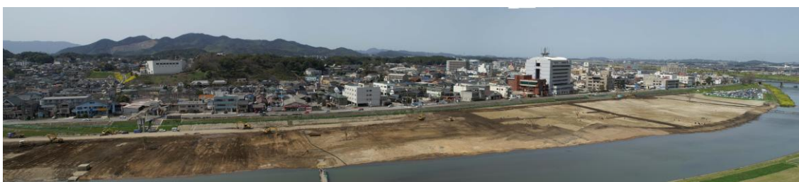
写真4-38 緩傾斜河岸の改修工事（2006年3月）
