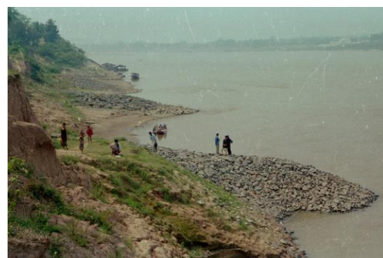
写真 4-10 完成した1,2,3,4号基（2000年4月）
