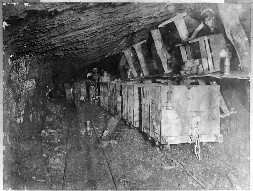
写真⑨. No 8.スラ函を使って石炭を切羽から片盤坑道に（住友忠隈炭坑第三坑）嘉穂郡穂波村忠隈 明治44年頃
