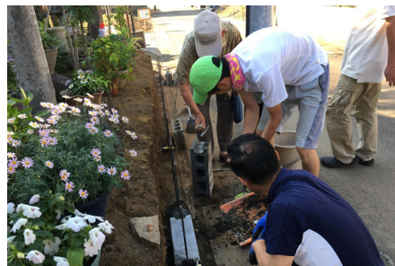
熊本地震被災地にて、耐震性を考えた拠点づくりの取り組み (2016年7月)
