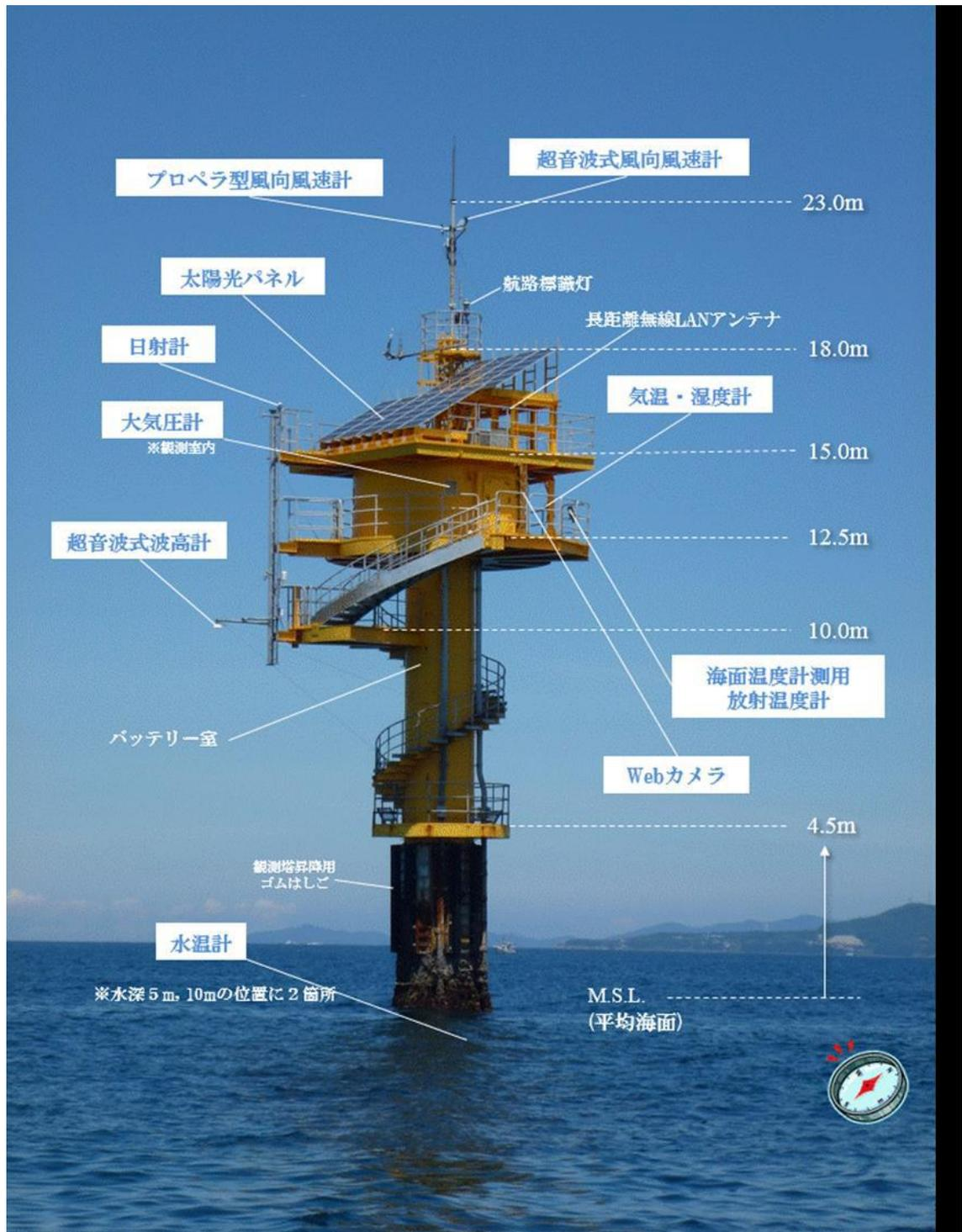
図 2.2 白浜観測塔の外観(白浜海象観測所 HP より)
