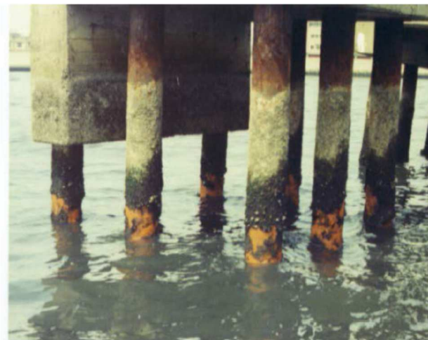
図-2.6 港湾鋼構造物のマクロセル腐食の例
