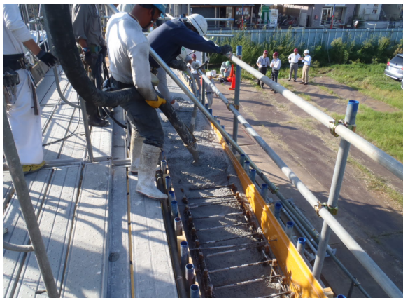
写真-5.5 コンクリートの打込み状況（壁）
