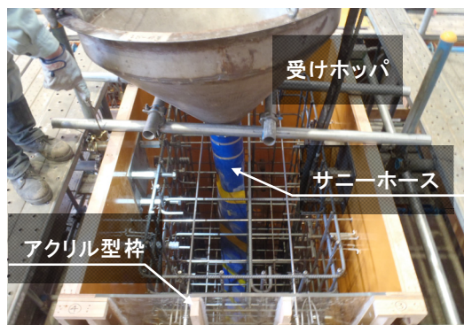
写真-5.1 打込み設備の配置状況
