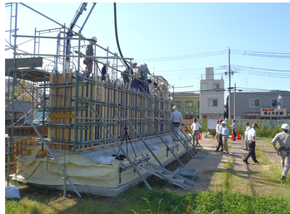
写真-5.5 コンクリートの打込み状況（壁）
