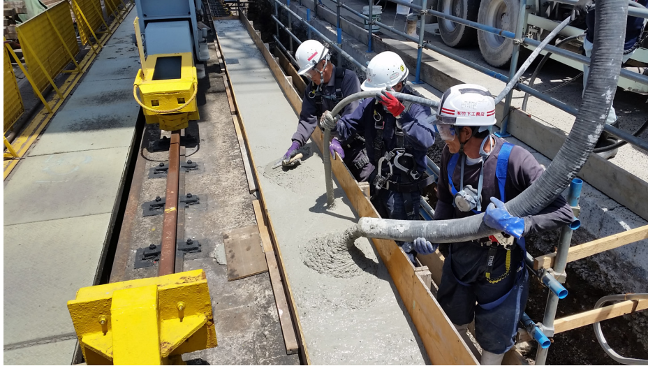
写真-6.5 コンクリートの打込み状況
