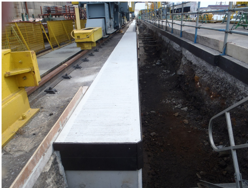
写真-6.6 脱枠後の出来栄え
