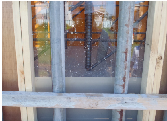
写真-5.7 改良 BC 14cm の充填状況
