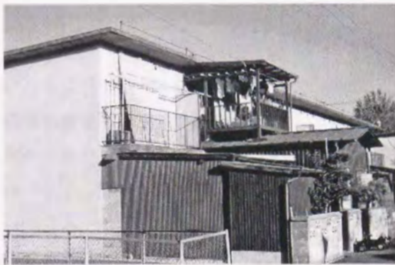
写真 2.4.6 増築している簡二タイプの住宅
