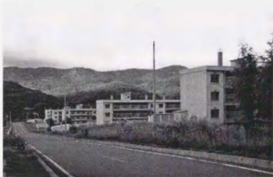
写真 2.4.9 空き家の多い改良住宅
