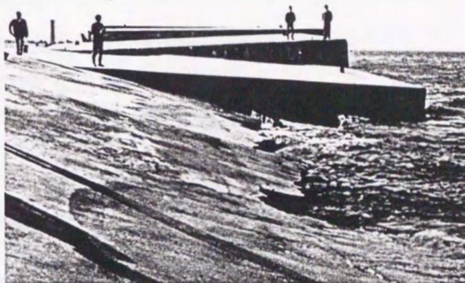
写真-8.1 堤体、上部工の被災状況 (右が港外側)
