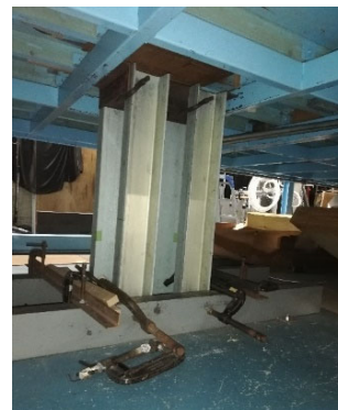
図 12 建屋床に備え付けられた支持台
