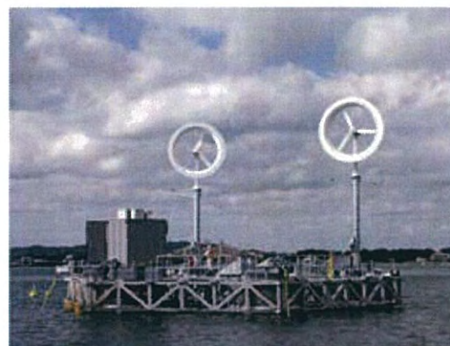
図10 博多湾プロジェクト(ステージI) 18m直径の六角形コンクリート浮体。3kWレンズ風車2基と2kW太陽光パネル搭載で計8kWのエネルギーファーム
