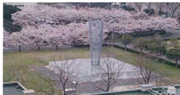
図 16 太陽光と風力を同時利用：ウィンドソーラータワー (WST) の試作。10mタワー高さ、15m四方の集熱部
