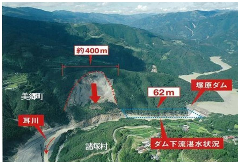
図 2-6 塚原ダム直下の崩壊
