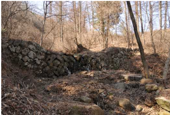
京大演習林時代につくられた砂防施設
