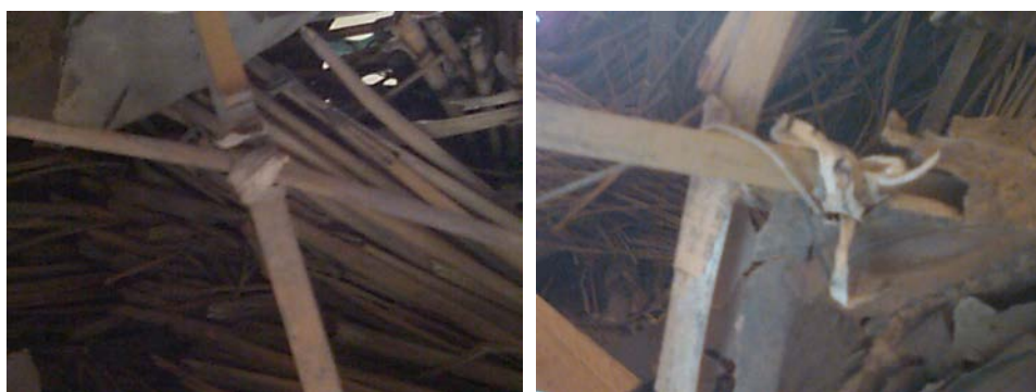
写真2-3-1 和紙による竹材同士の固定 写真2-3-2 剥離したテープ状和紙と乖離した竹材
