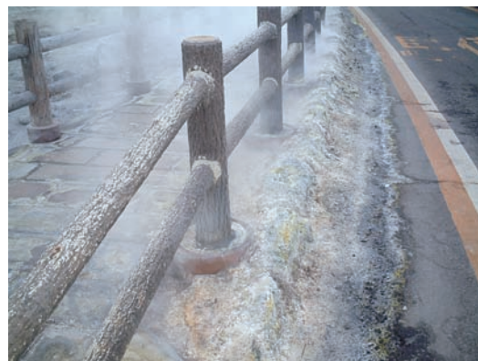
写真8 硫酸劣化の事例
