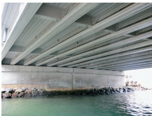
写真5 電気防食工法の事例
