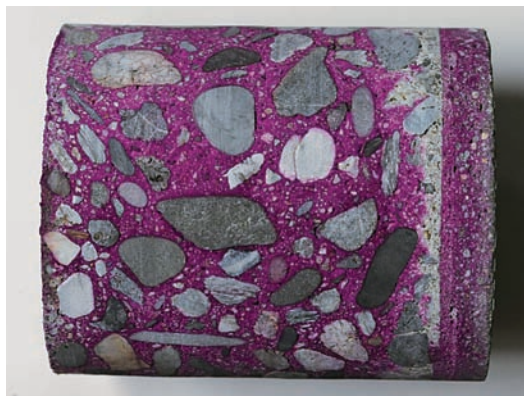
写真7 壁の中性化状況
