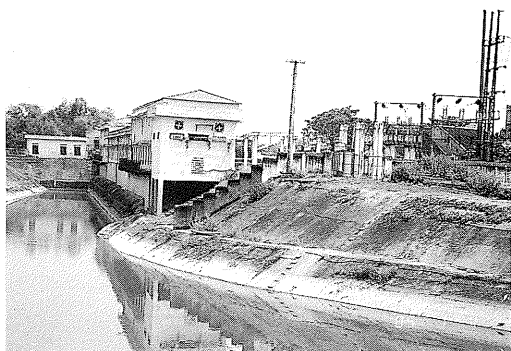
写真4 灌溉排水管理組合管理下の主揚水機場 (Bac Ninh 県).
