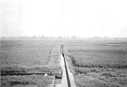
写真12 三次水路 (Ha Noi 市 Tuliem 郡). 写真11の二次水路に直角.
