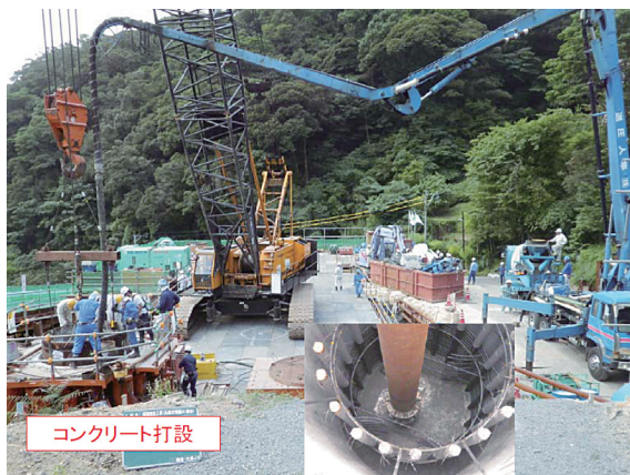
写真2 A1橋台基礎の打設状況
