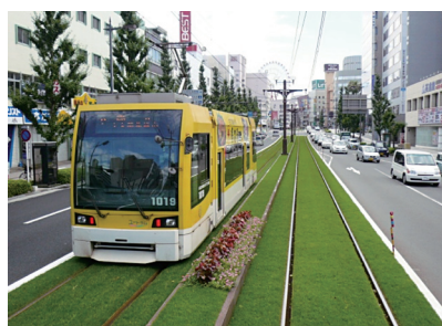
写真6 鹿児島市電の芝生軌道敷
