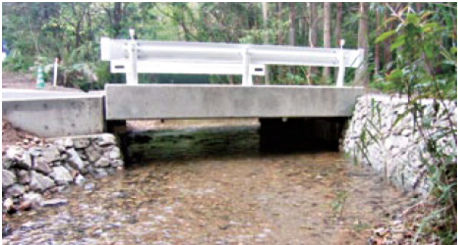
写真4 シラスコンクリート PC 橋桁
