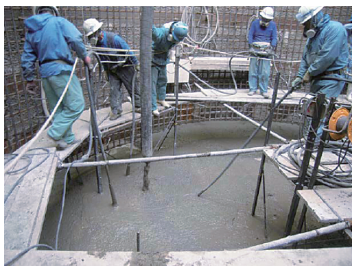
写真1 P1橋梁基礎の打設状況
