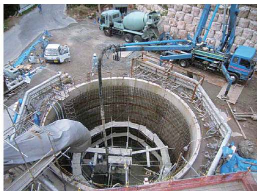
写真1 P1橋梁基礎の打設状況
