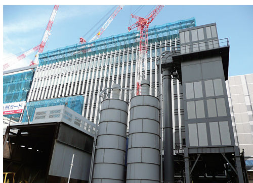
写真6 工事中の博多駅ビル
