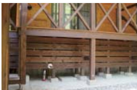
12. 居室床外観 (高床式)
