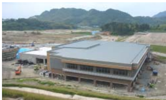
理系図書館工事状況 (H16・5月末)
