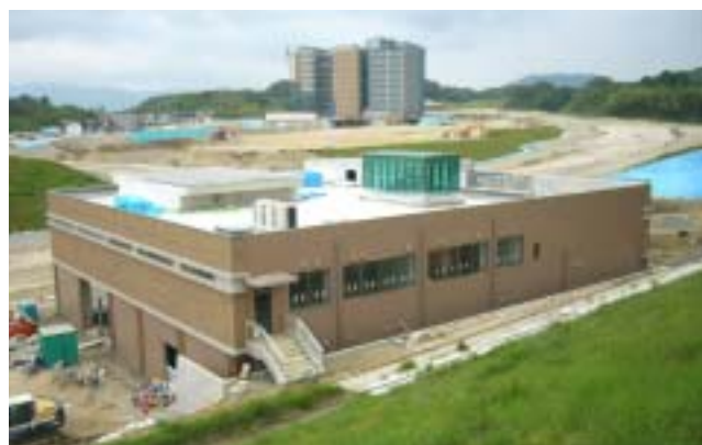
エネルギーセンター工事状況 (H16・5月末)
