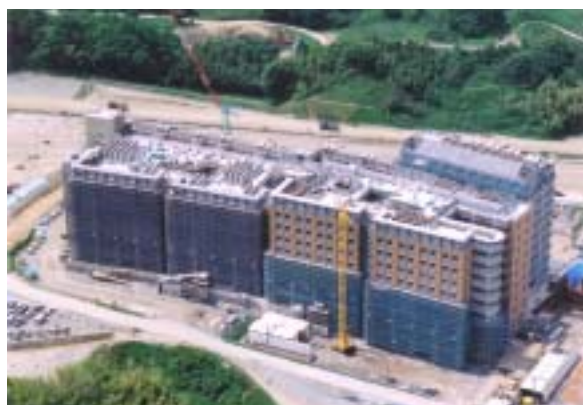
研究教育棟Ⅱ・Ⅲ工事状況 (H16・5月末)
