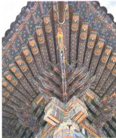
ソラクサンレンヌンサ 雪嶽山神興寺の軒先の構造
