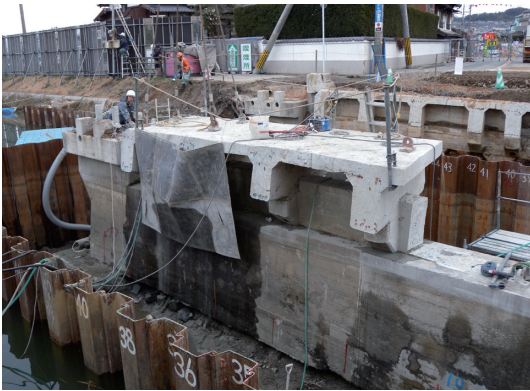
写真3 橋梁解体現場
