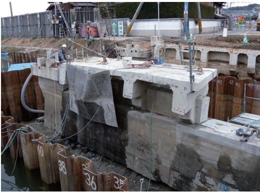
写真3 橋梁解体現場
