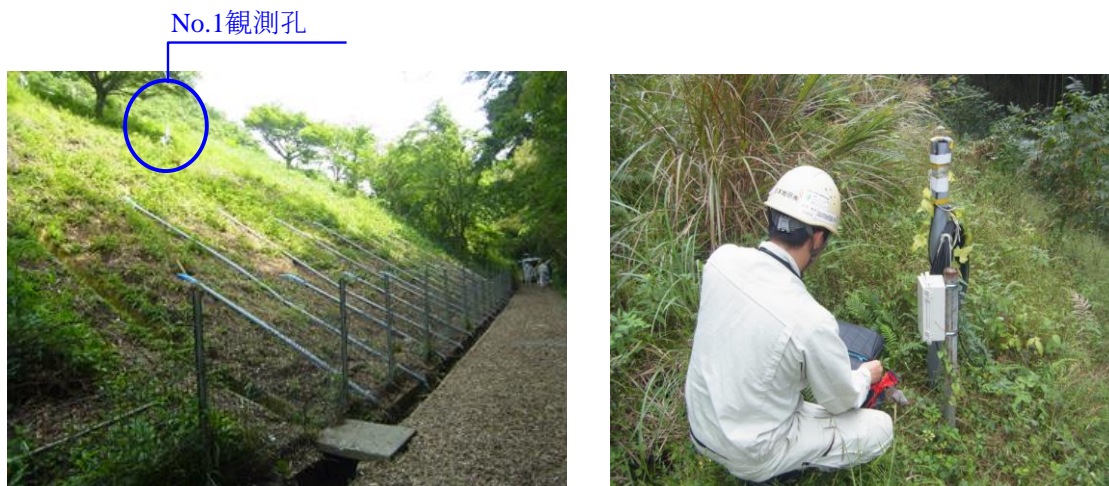
写真-5.3 地下水計の設置状況 (No.1観測孔)
