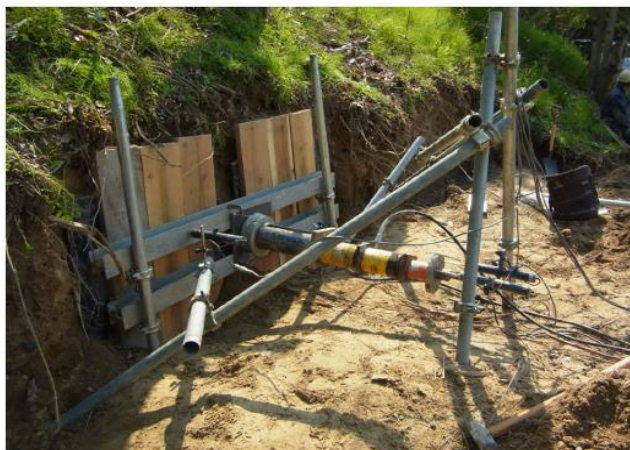
写真-4.4 引抜き抵抗試験状況
