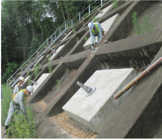
写真-2.2 アンカーの近接目視・打音点検状況
