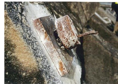
b) コンクリートキャップ撤去
