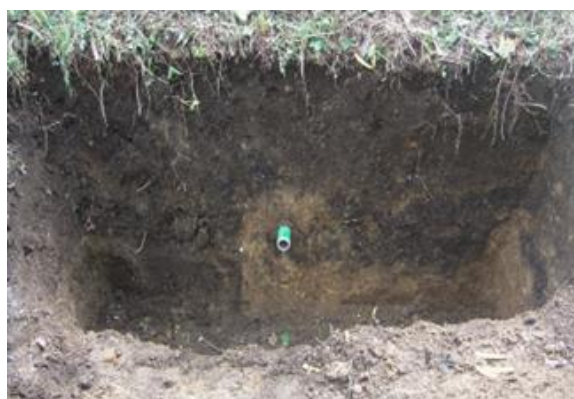
写真-4.5 SDPRの掘り起し状況
