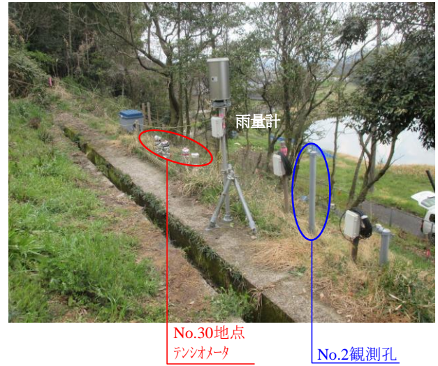
(2) 盛土小段の設置状況
