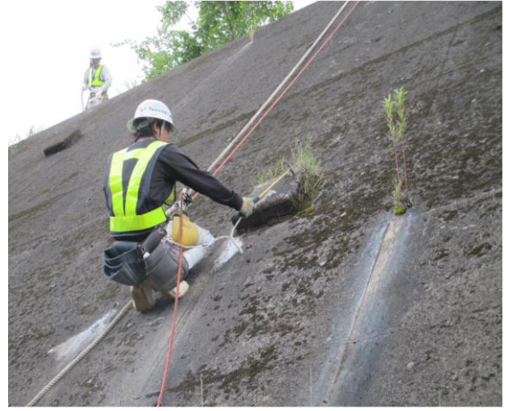
写真-2.2 アンカーの近接目視・打音点検状況
