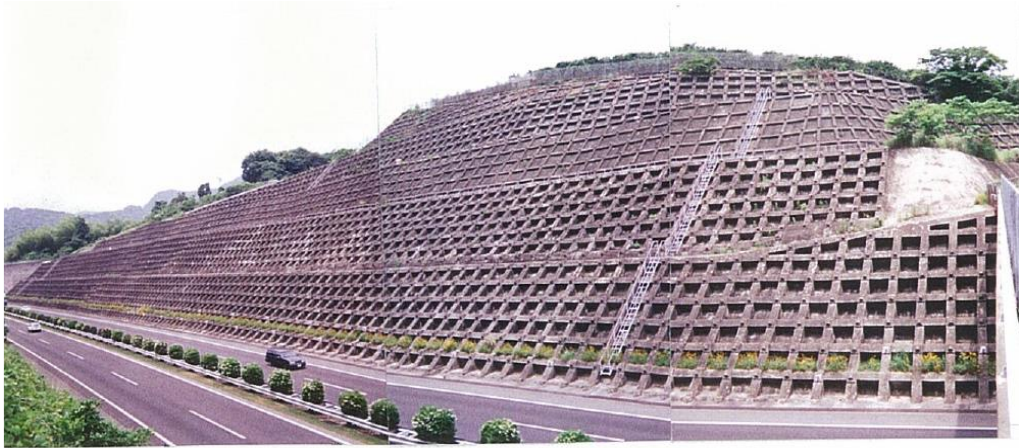
写真-2.4 検討のり面の全景
