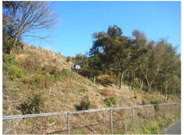
(2) 対策後の盛土状況
