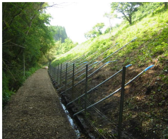
写真-5.2 SDPRによる補強対策状況（対策後）
