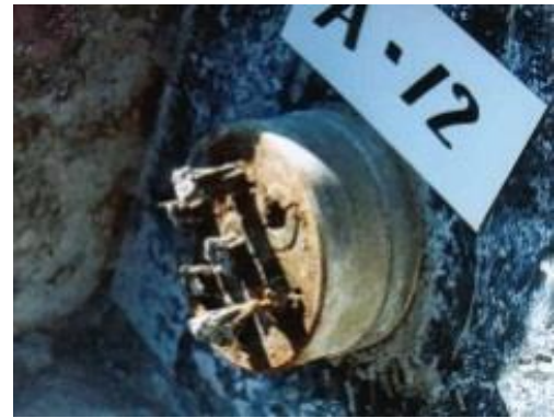
(2) アンカーの引込み
