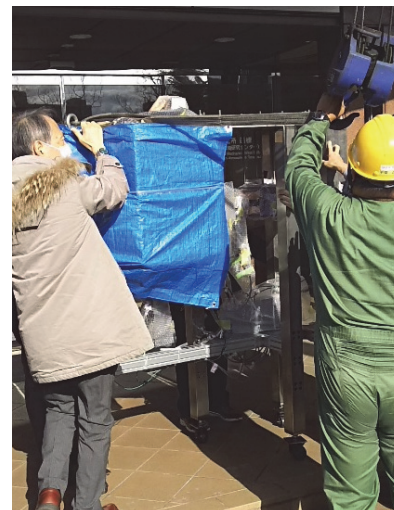
図 3 30kV 軽イオン照射装置搬入の様子
