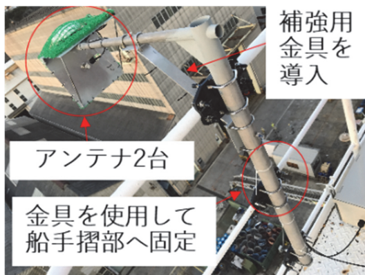
図 4 設置後のアンテナ
