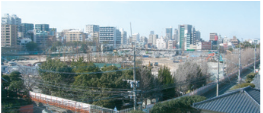
解体工事も終わりに近づく(2011年2月26日浪人谷より、筆者撮影)
