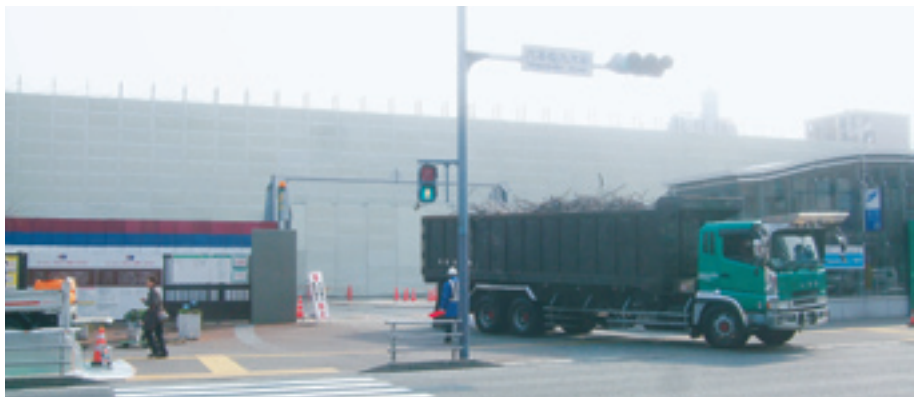
解体工事が進む本館(2011年2月25日、筆者撮影) (交差点・信号横にある「六本松九大前」の補助標識はいまだ残る)
