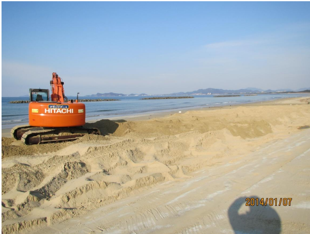
図-1.4 重機による堆積した砂の押し戻し作業
