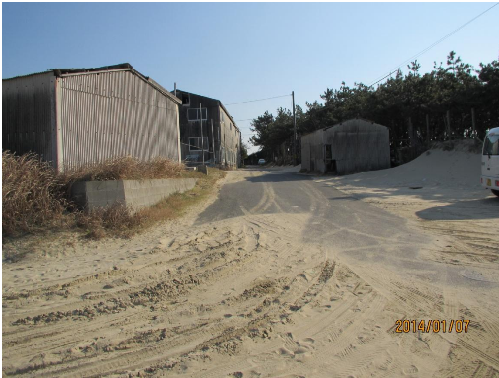
図-1.5 海岸と住宅地を結ぶ道に堆積した砂
