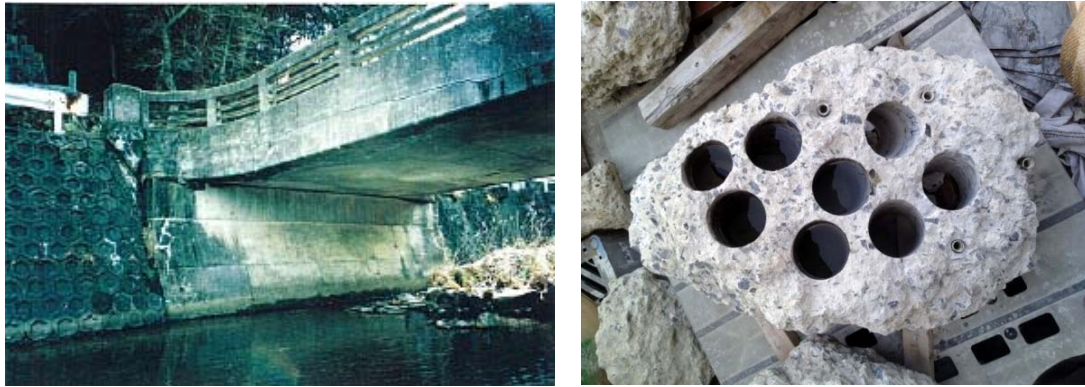
写真-5.4 前川橋外観および試験体
