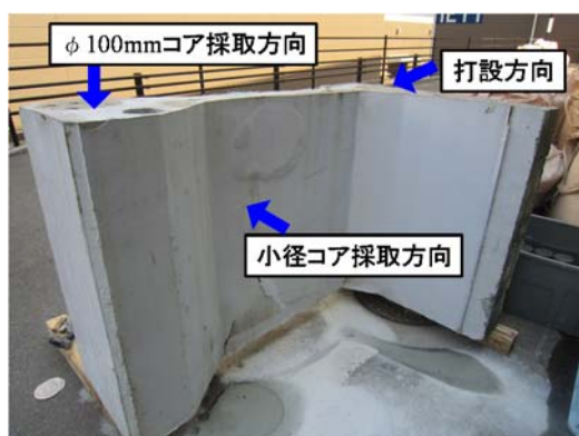
写真-3.4 PC解体T桁 切り出し部材外観
