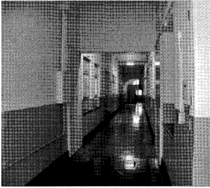
写真1 本部第一庁舎の内壁
