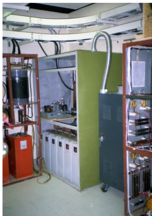
図 17. トロイダル磁場用電源
